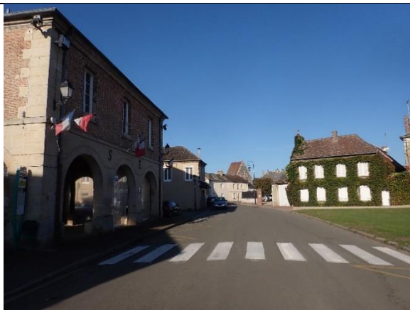
Photo 53 : Halles situées place de l'Église, In situ (Source : IEA)
