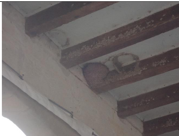
Photo 54 : Nid d'hirondelles situés sous les halles de la place de l'Église, In situ (Source : IEA)
