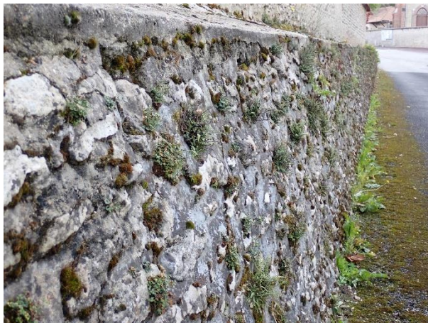
Photo 11 : Végétation riche en fougère se développant sur un mur (in situ - IEA)
