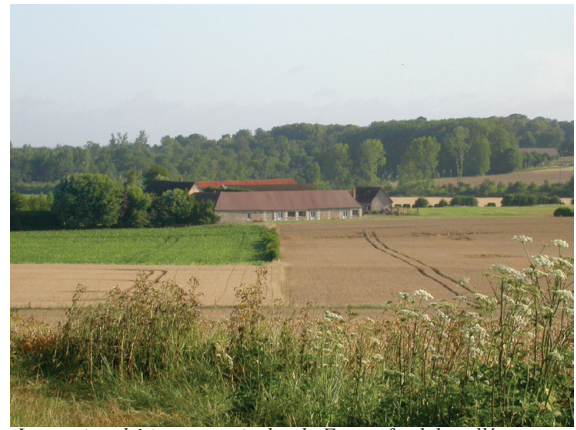
Les anciens bâtiments agricoles du Fay en fond de vallée
